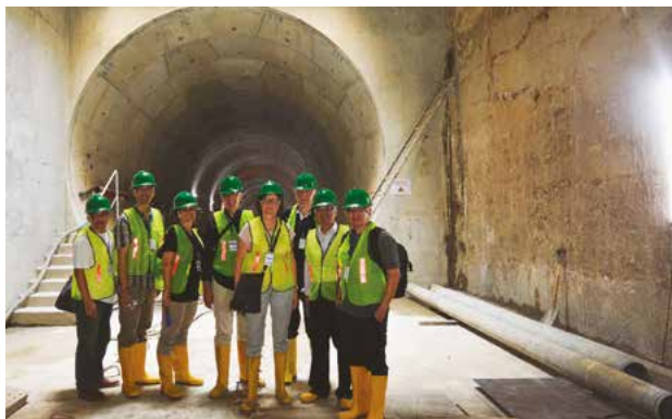
Kunjungan ke lokasi pembangunan MRT di Jakarta | Besuch auf der Baustelle der Metrolinie in Jakarta
